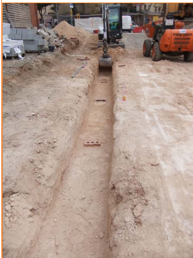
Foto 48. Rasa 12 del segon col·lector.
