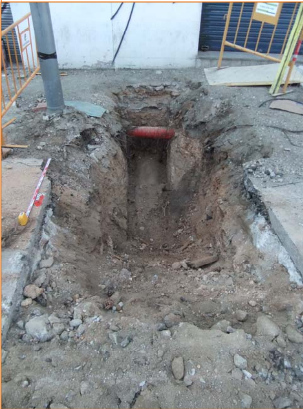
Foto 22. Rasa de connexió 4.
