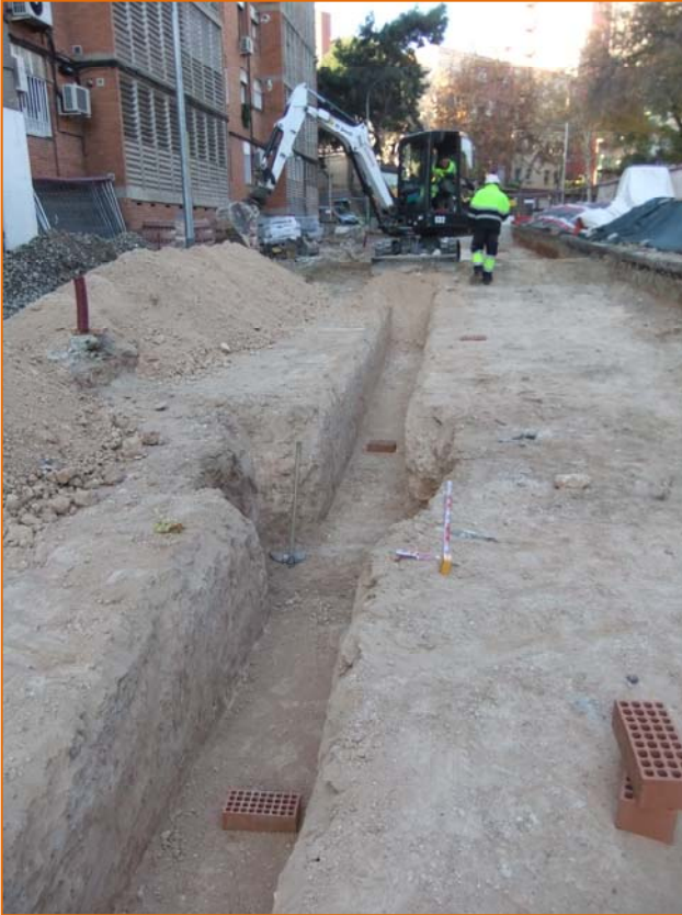
Foto 45. Rasa 11 del segon col·lector.
