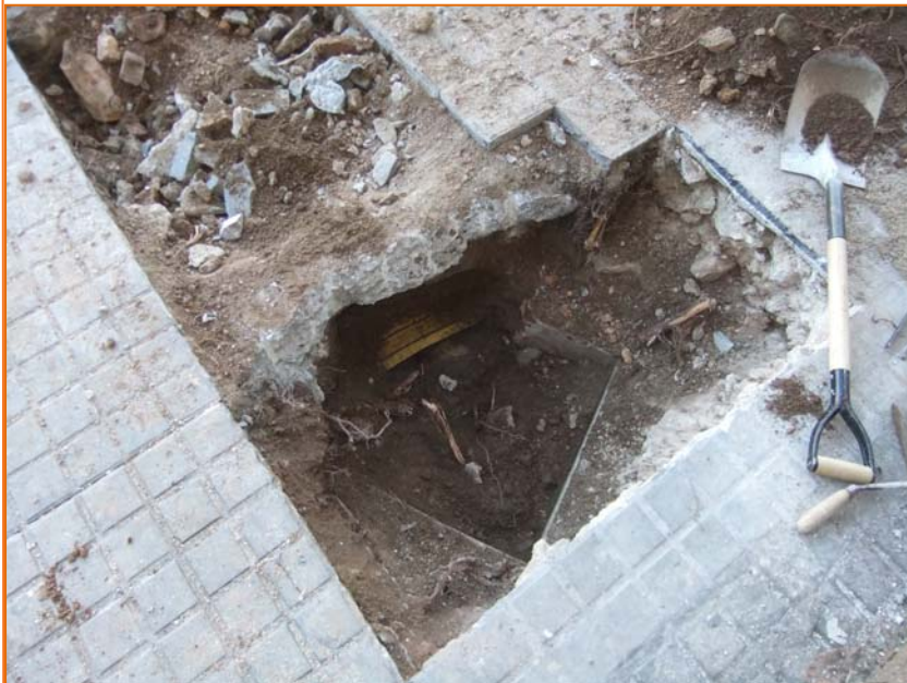
Foto 2. Cala d'obra 1. Arqueta de serveis.
