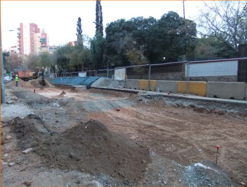
Foto 33. Caixó de la carretera.
