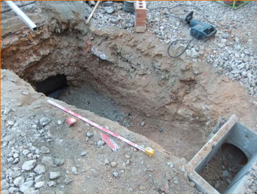
Foto 39. Rasa 9A del segon col·lector. Connexió amb col·lector general.
