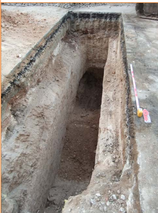
Foto 18. Rasa de connexió 2.
