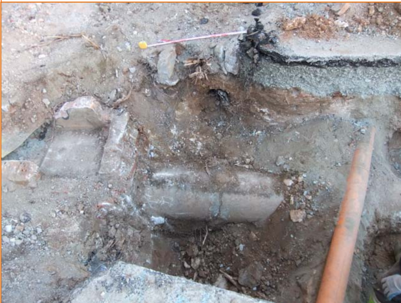
Foto 28. Rasa de connexió 7.
