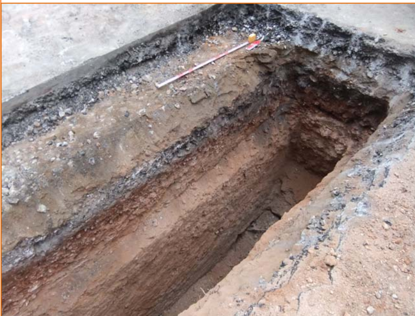
Foto 16. Rasa de connexió 1.
