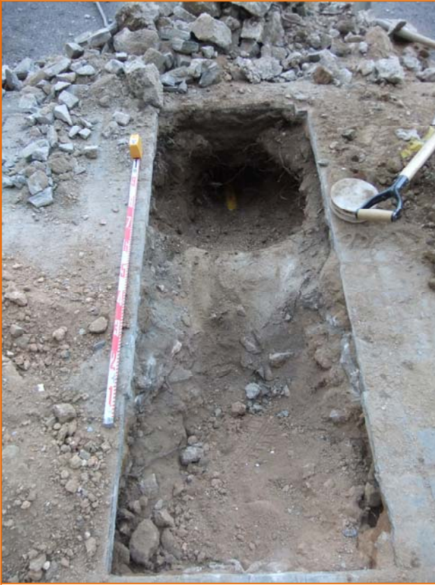
Foto 5. Cala d'obra 3. Serveis i estrat UE 004.
