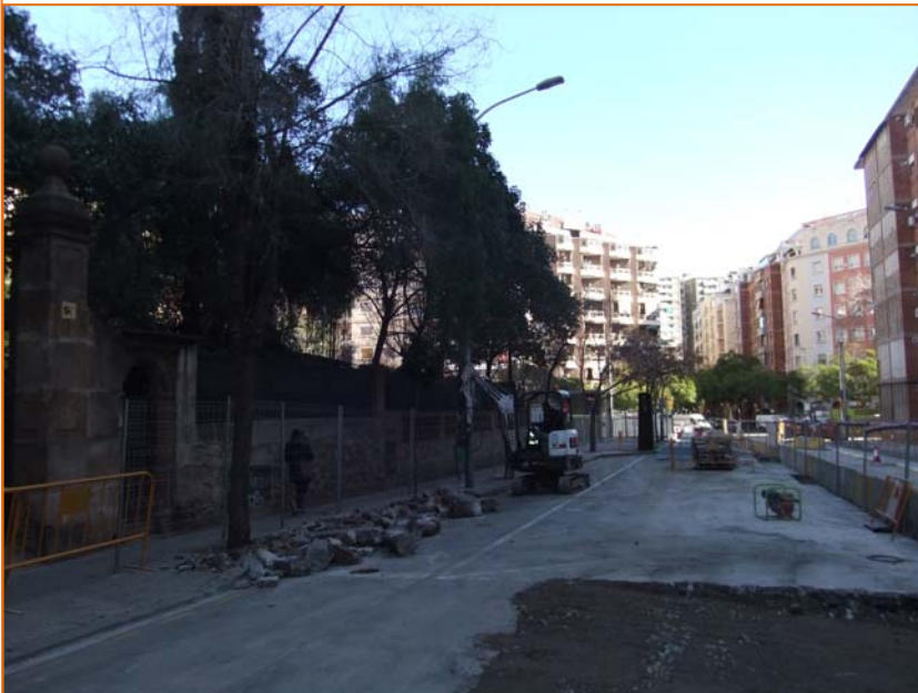
Foto 58. Demolició de la vorera.
