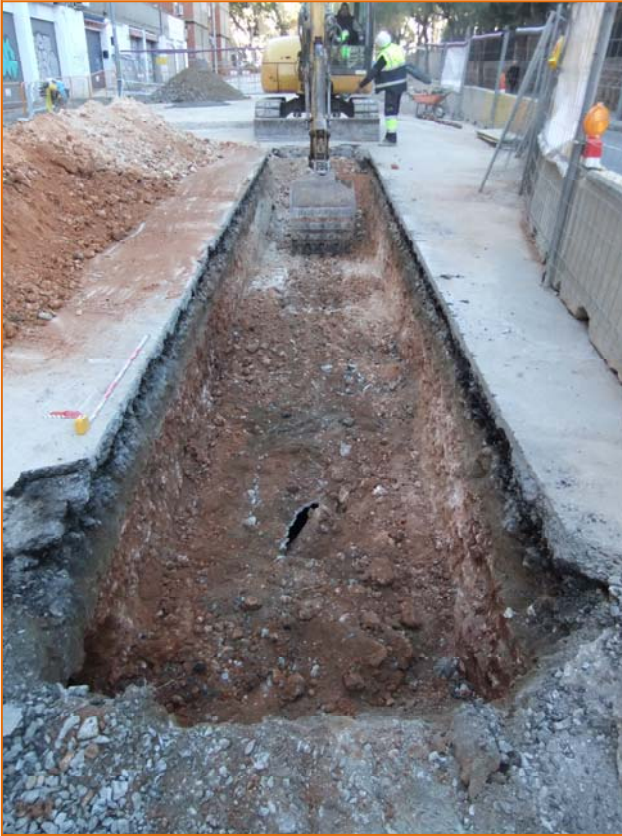
Foto 31. Rasa del col·lector general.
