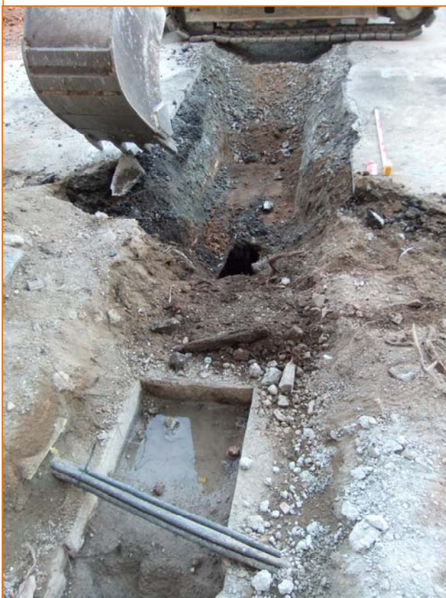
Foto 26. Rasa de connexió 6.
