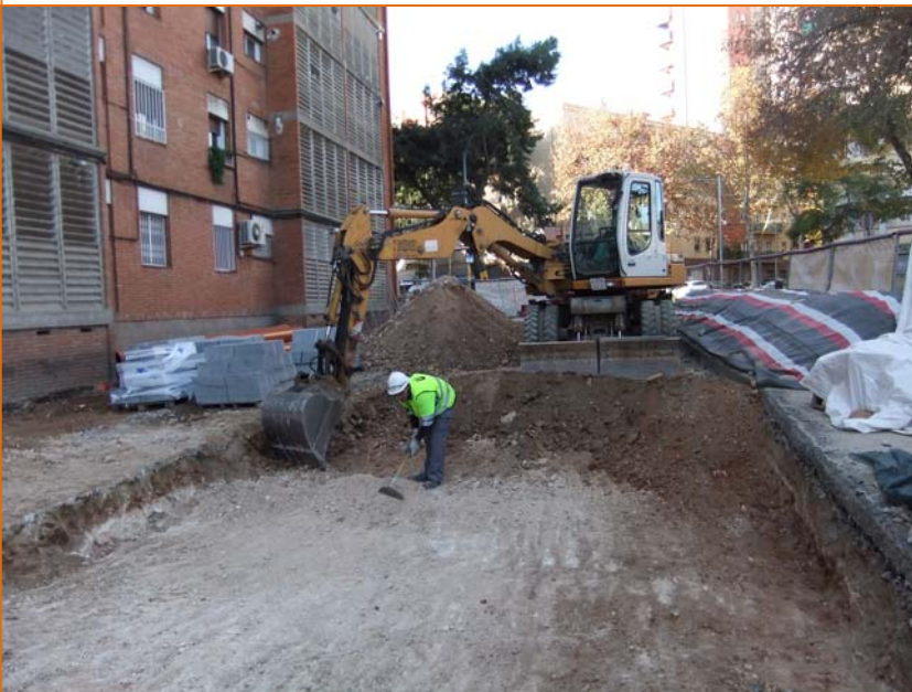
Foto 34. Caixó de la carretera.
