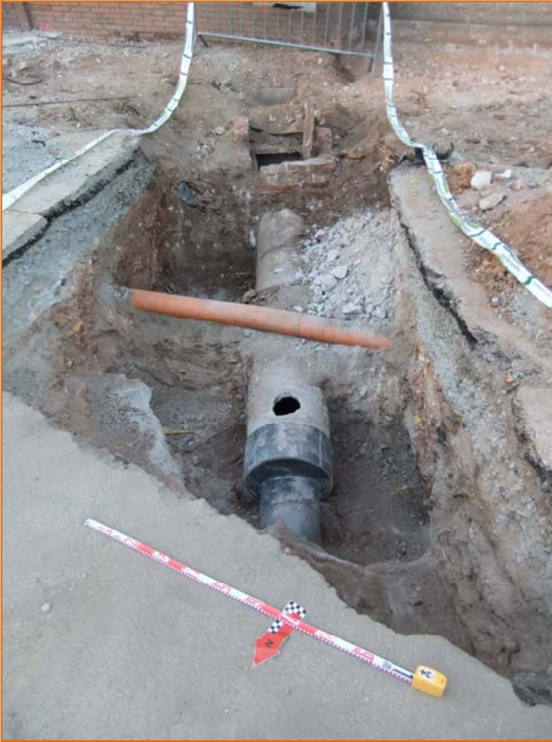
Foto 29. Rasa de connexió 7.
