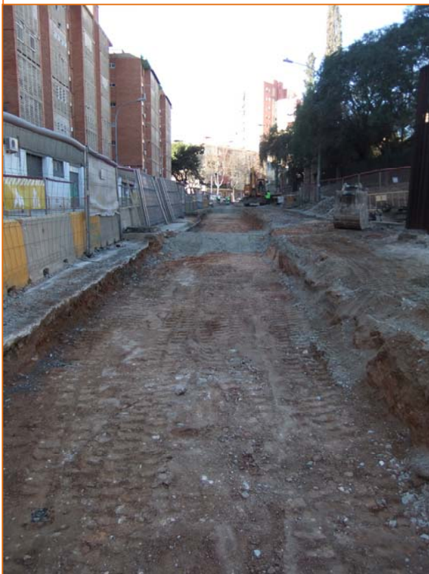
Foto 62. Caixó de la carretera.
