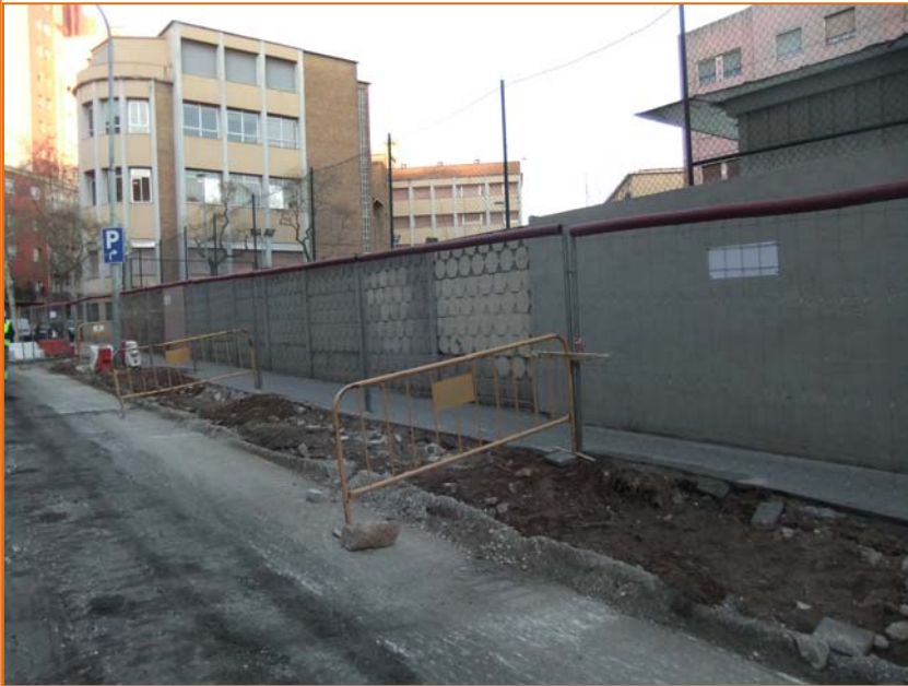
Foto 59. Demolició de la vorera
