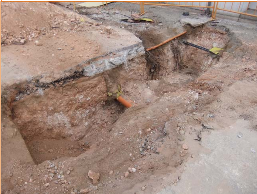
Foto 24. Rasa de connexió 5.
