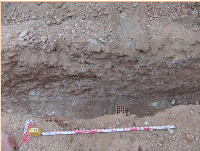
Foto 43. Rasa 10 del segon col·lector.
