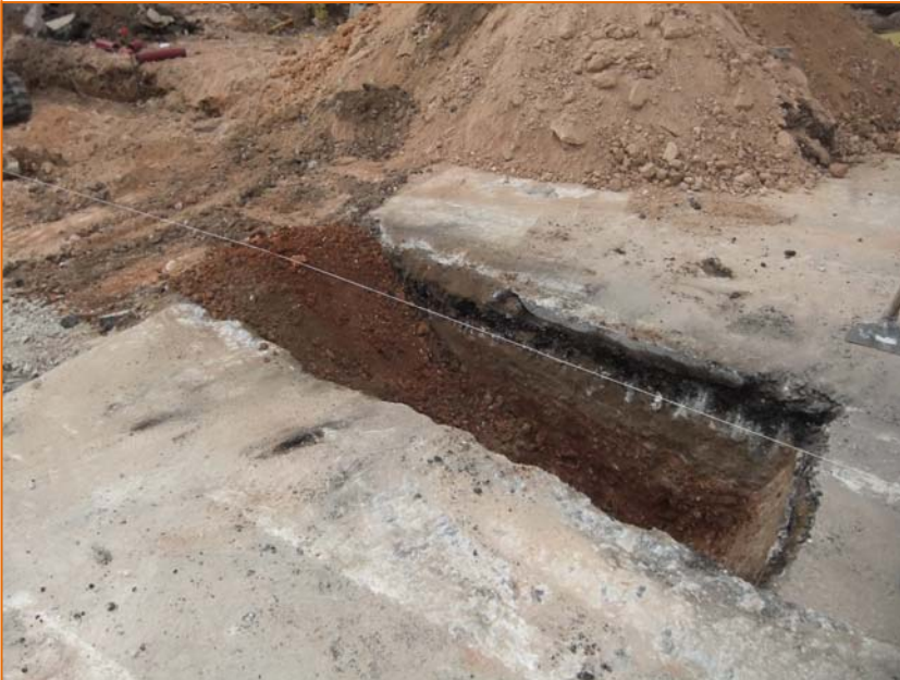
Foto 50. Rasa 12 del segon col·lector.
