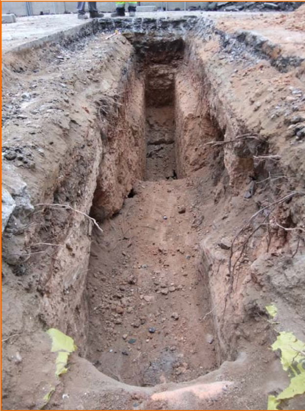
Foto 15. Rasa de connexió 1.
