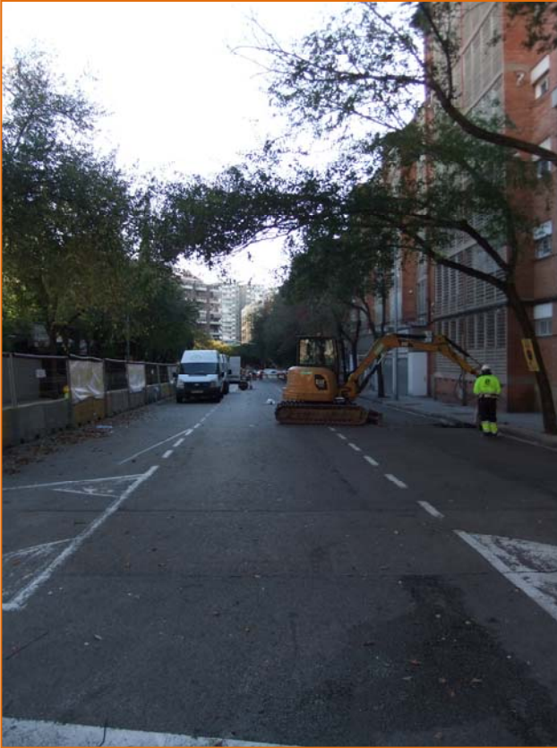
Foto 1. Ubicació general de l'obra.
