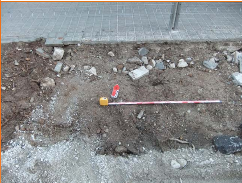
Foto 60. Demolició de la vorera
