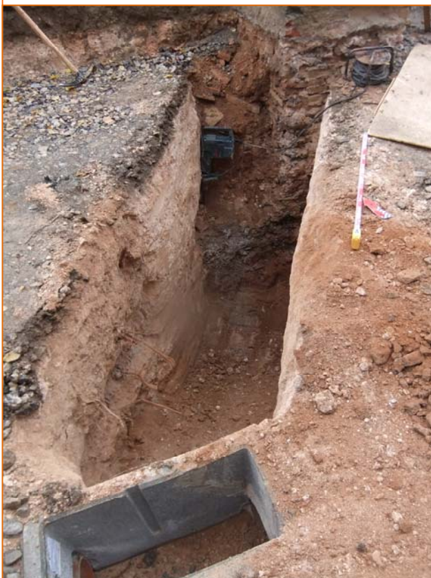
Foto 47. Rasa 11 del segon col·lector. Connexió amb col·lector general.
