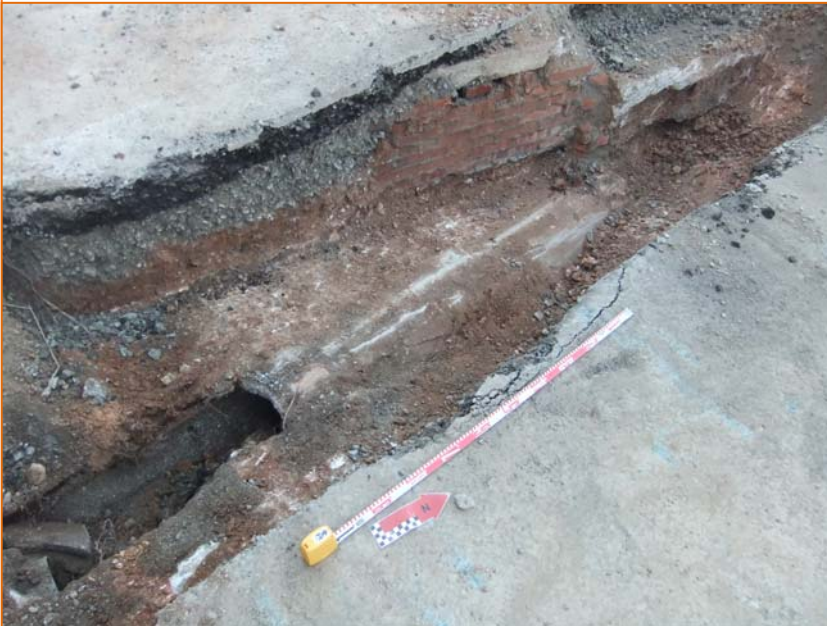
Foto 27. Rasa de connexió 6.
