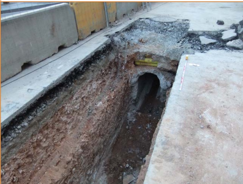
Foto 32. Rasa del col·lector general.
