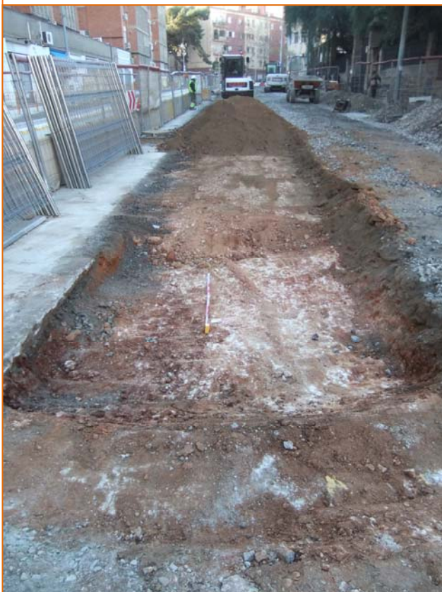
Foto 61. Caixó de la carretera.
