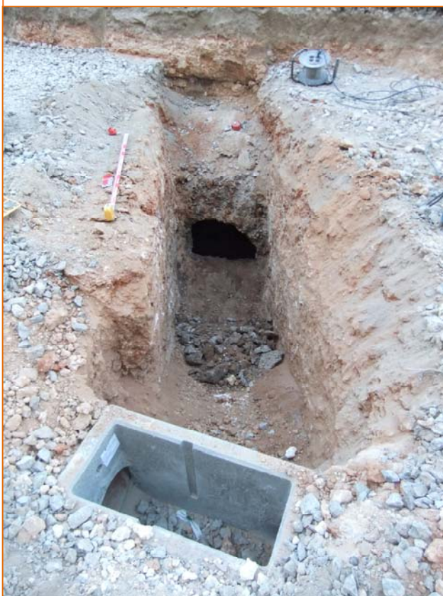
Foto 44. Rasa 10 del segon col·lector. Connexió amb col·lector general.
