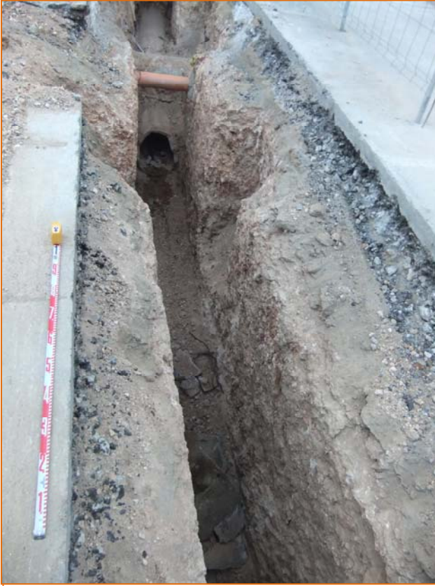
Foto 23. Rasa de connexió 4.
