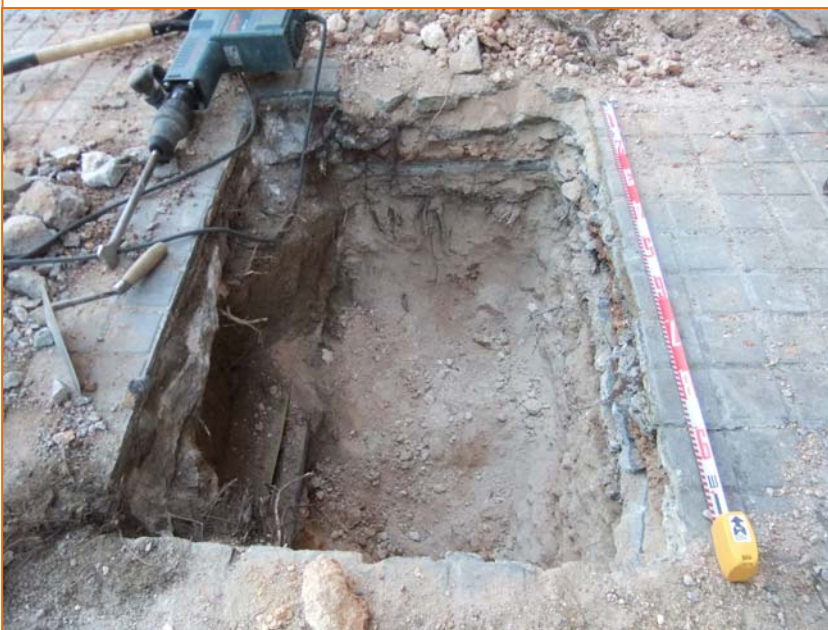
Foto 4. Cala d'obra 2. Serveis i estrat UE 004..
