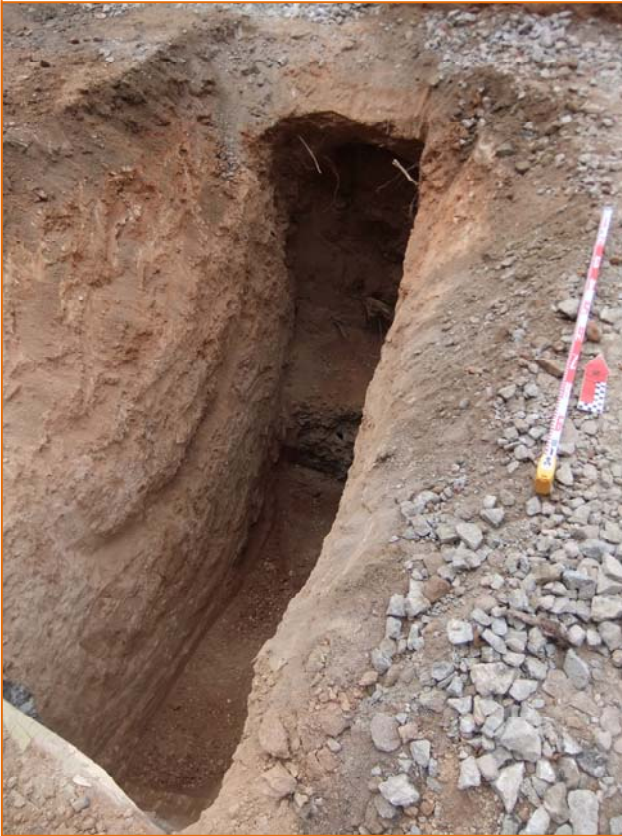
Foto 51. Rasa 12 del segon col·lector. Connexió amb col·lector general.
