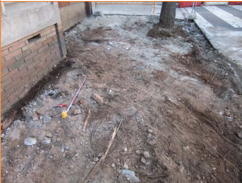
Foto 12. Demolició de la vorera. UE 004.
