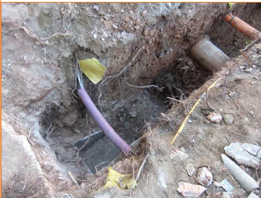
Foto 17. Rasa de connexió 1.
