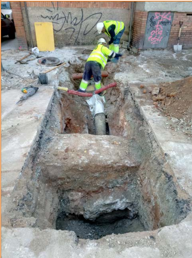
Foto 30. Rasa de connexió 8.
