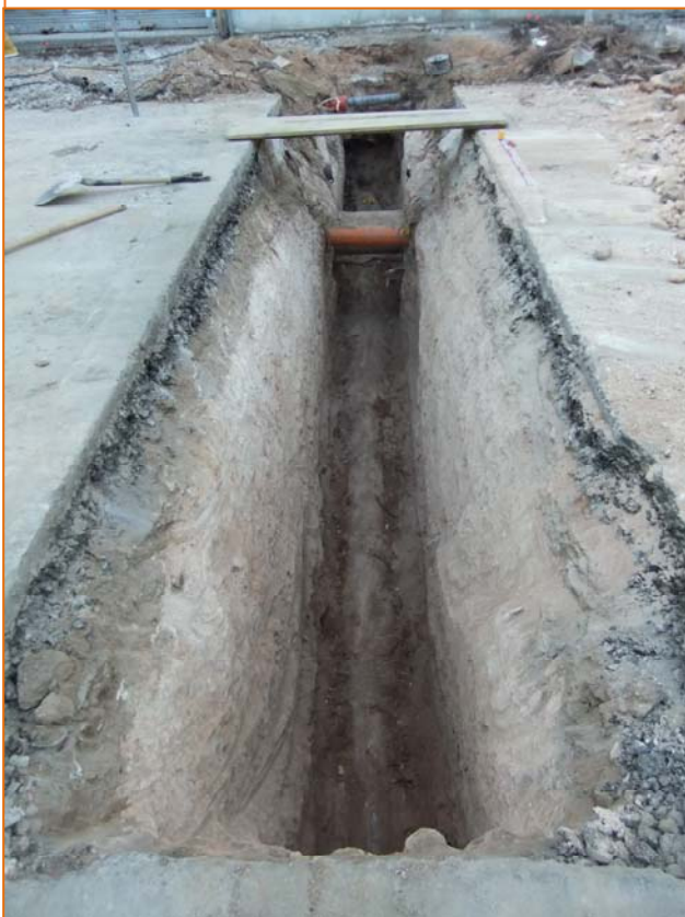
Foto 20. Rasa de connexió 3.
