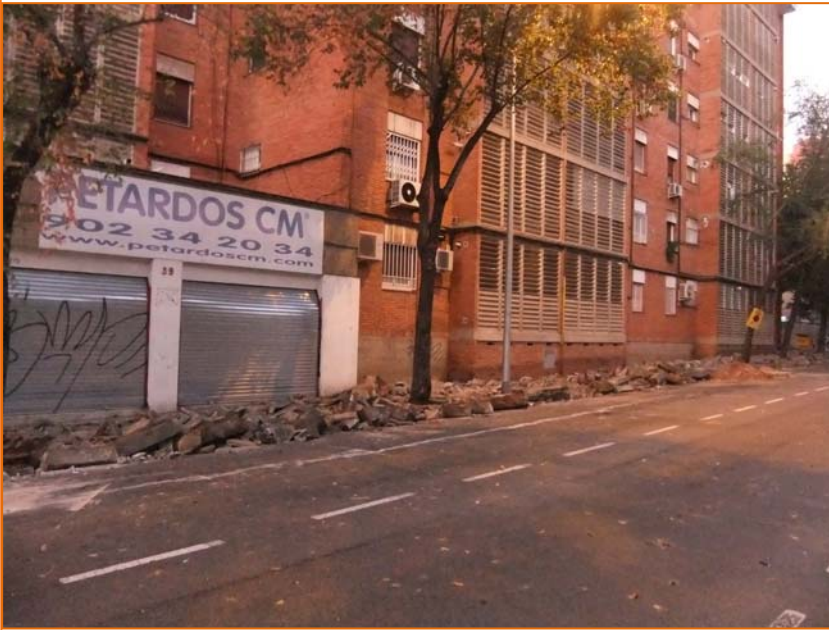
Foto 11. Demolició de la vorera
